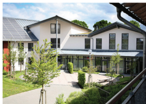
Technologiezentrum für Zukunftsenergien Lichtenau
