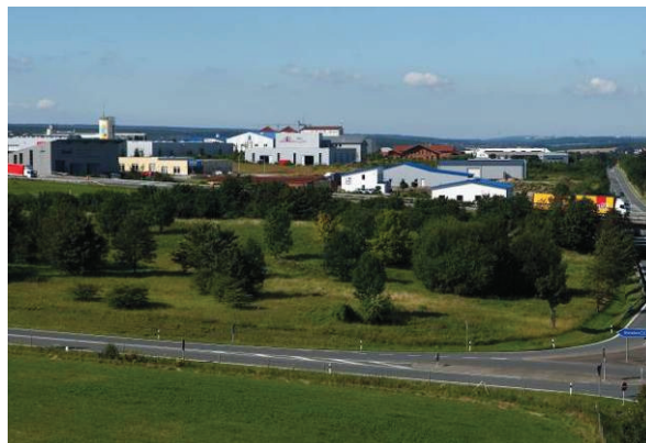
Blick auf das Gewerbegebiet an der A 33
