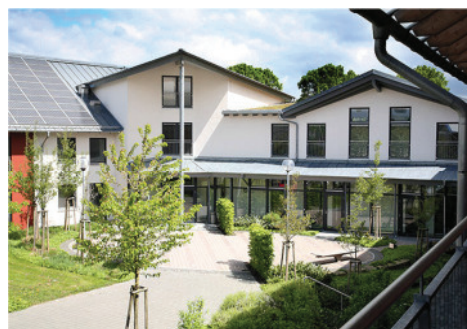
Technologiezentrum für Zukunftsenergien Lichtenau
