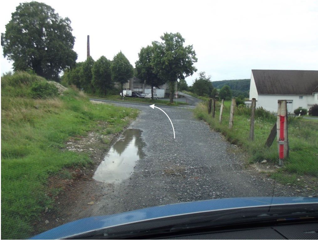
Bild 07: Bypass, Zufahrt L754/Finkestraße, Ortslage Atteln
