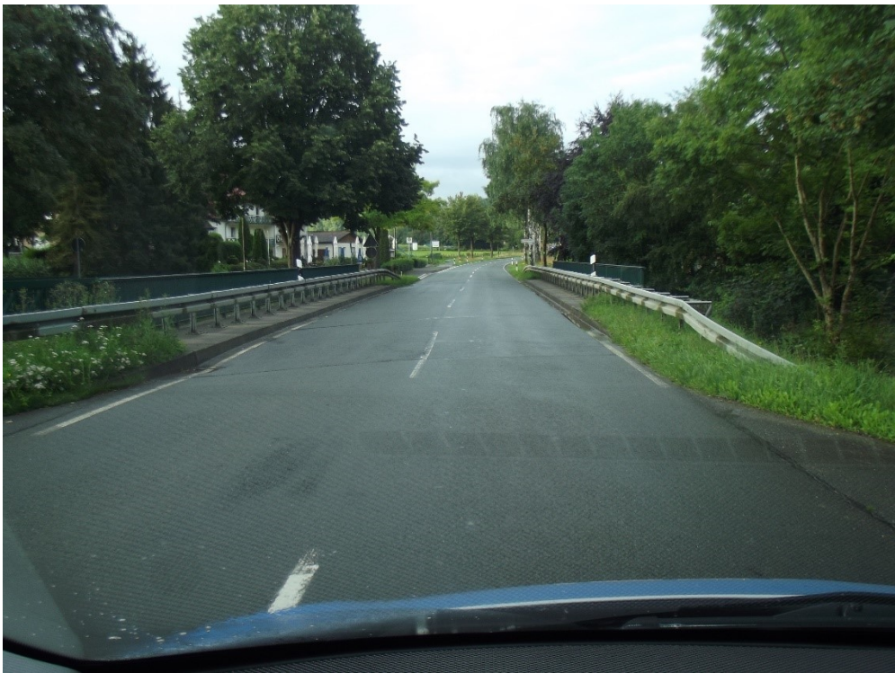
Bild 04: K1, Fahrtrichtung Bypass, über Brückenbauwerk
