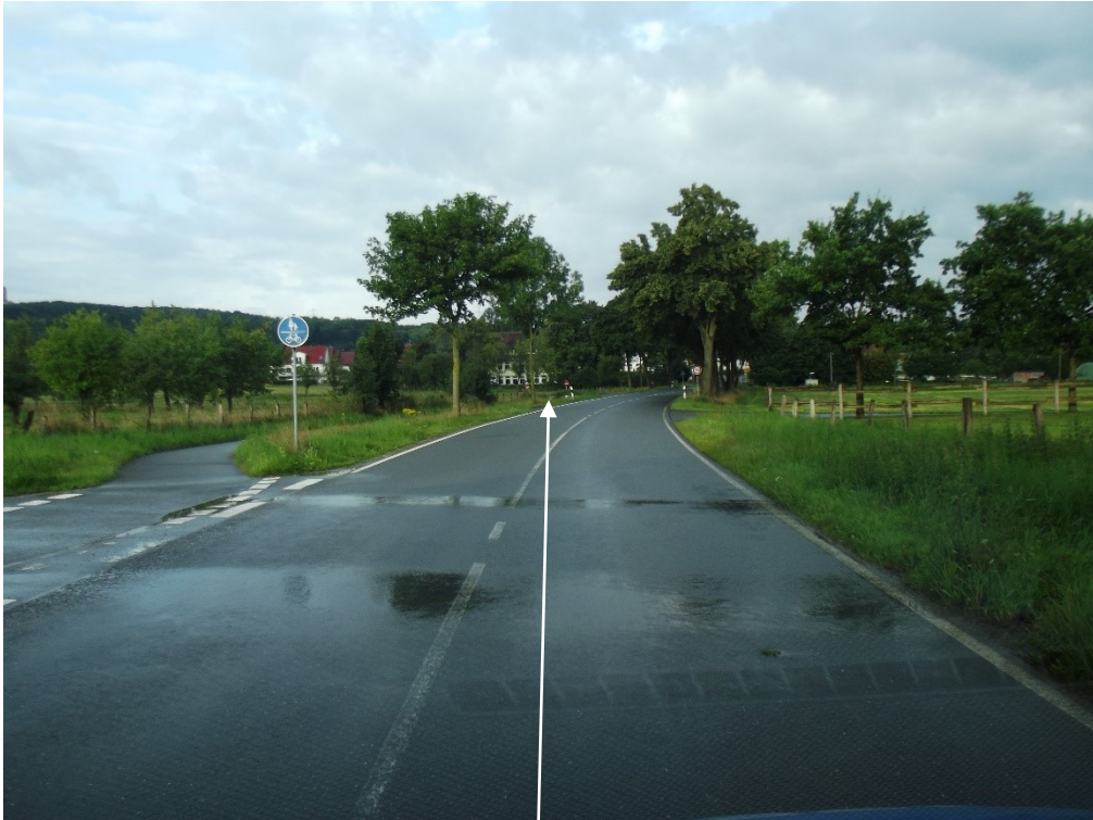
Bild 05: K1, Fahrtrichtung Bypass, gemeinsamer Geh- u. Radweg linksseitig (VZ240)
