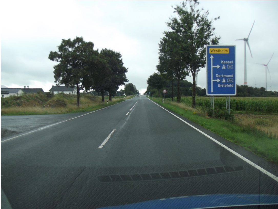
Bild 15: L817 Fahrtrichtung A44 AS Lichtenau
