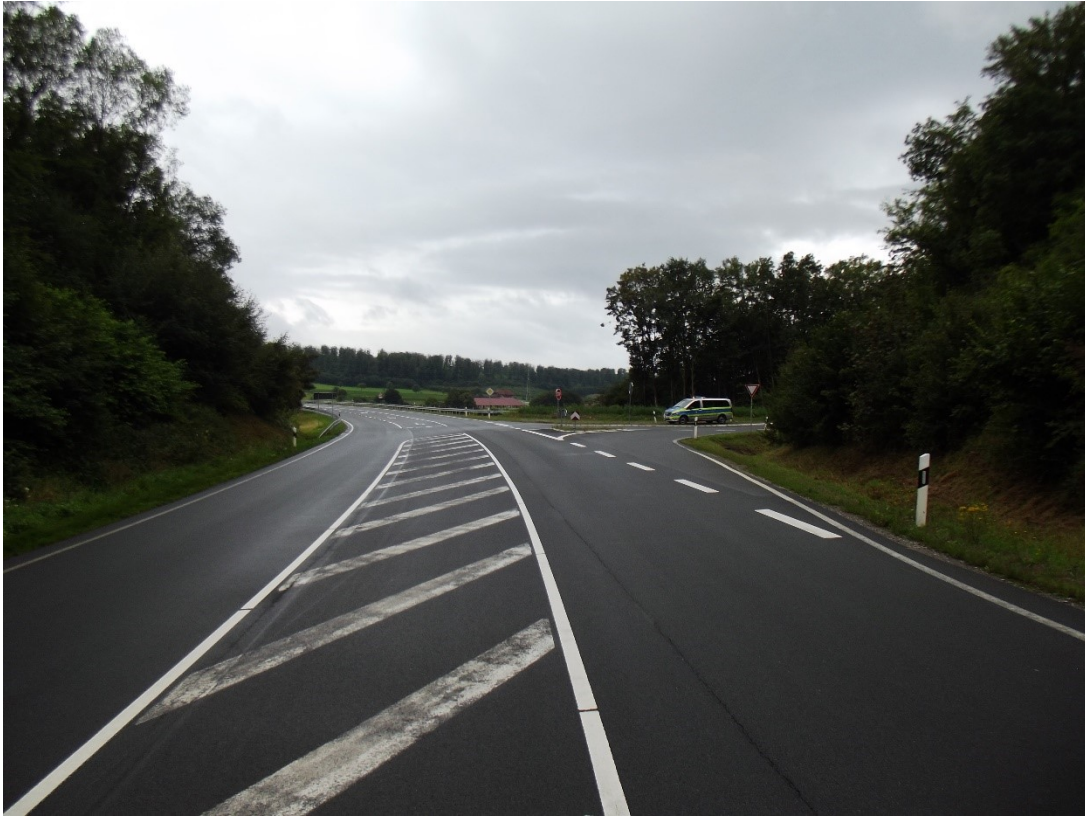
Bild 13: Einmündung L817/L754, Fahrtrichtung A44 AS Lichtenau
