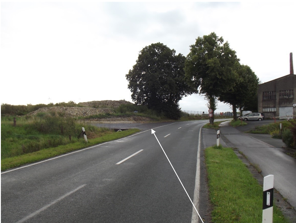
Bild 08: L754, Fahrtrichtung Husen, Ausfahrt Bypass (L754 Straßenbreite ca. 7,00m)
