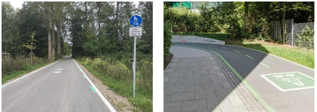
Abb. 18 Gestaltungsbeispiele mit Randmarkierung (links) (Foto: SHP Ingenieure) und mittiger Leitlinie im Kurvenbereich (rechts)<sup>2</sup>
