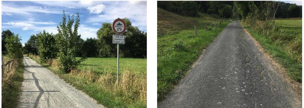
Abb. 13 Abschnitte mit wassergebundener Wegedecke (links) und punktuellen Oberflächenschäden (rechts) (Fotos: SHP Ingenieure)
