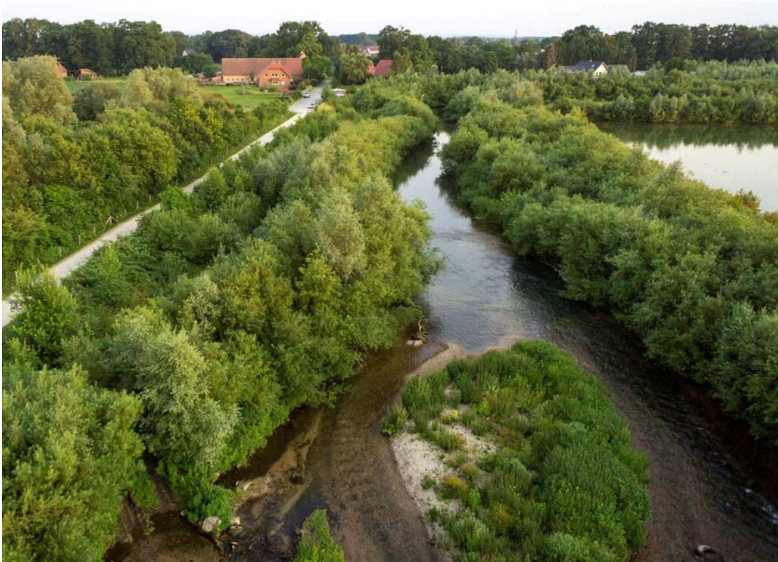
Abb. 13: Blick von Norden auf die Umflut zwischen Nesthauser Grundsee und Hochwasserentlastungsdamm (im Hintergrund der Hof Neesen)
