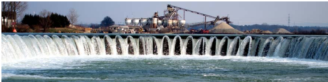
Abb. 1: Auslaufbauwerk des Lippesees (im Hintergrund das Kieswerk am Nordufer des Sees)
